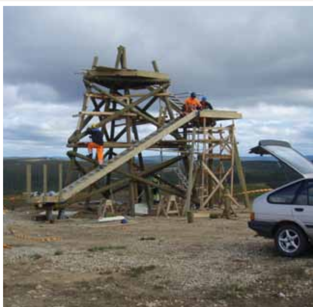
Uusi torni kohoaa Kaunispään huipulle kesällä 2011.
