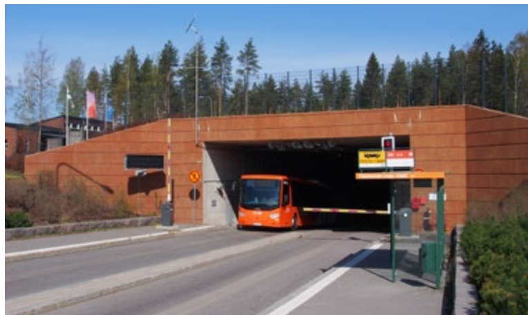
Den 1,2 km långa tunneln i Svedängen går under Helsingfors centralpark från Svedängen till Kungseken.
