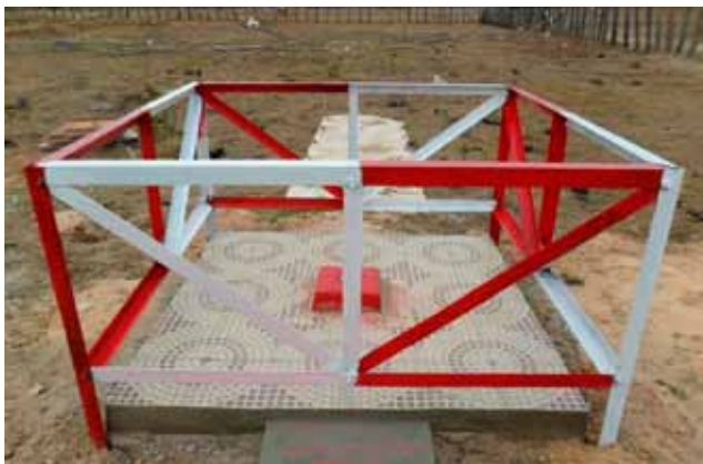
Laosin kansallisen standardin mukaan rakennettu ensimmäisen luokan geodeettinen kiintopiste suoja-aitoineen.
