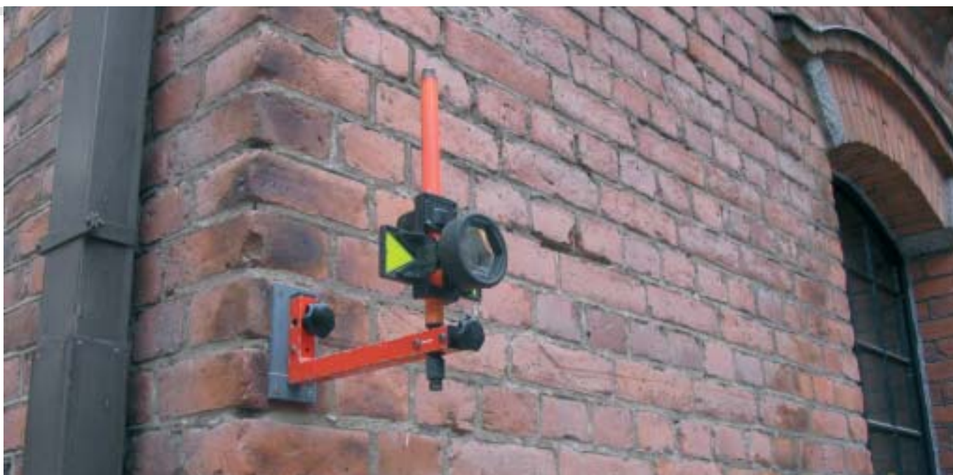
Mittauskunnossa oleva seinäpiste.
