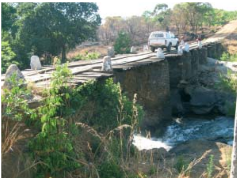
Hyväkuntoinen puukantinen silta.
