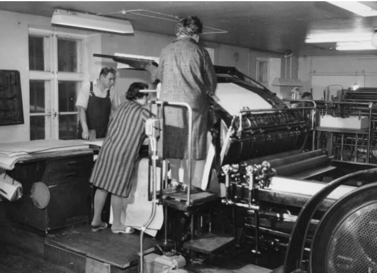
Maanmittaushallituksen Kivipainon laakaoffsetpainokone. Työn touhussa mm. Jorma Välinen ja Irma Aaltonen.
